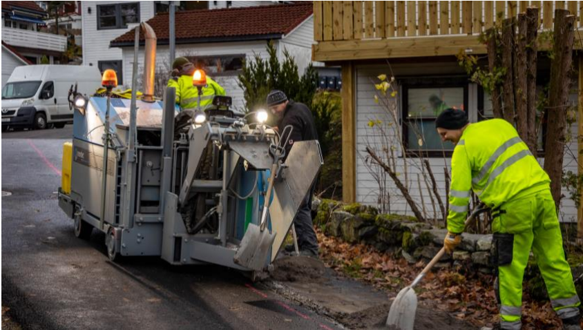
Figur 6 - Eksempel på microtrench-teknikken (foto: Flemming Skahjem-Eriksen )
