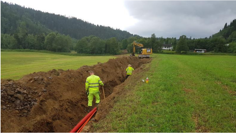
Figur 10 - Eksempel av en stor grøft med gravemaskin (foto: LW Entreprenør)
