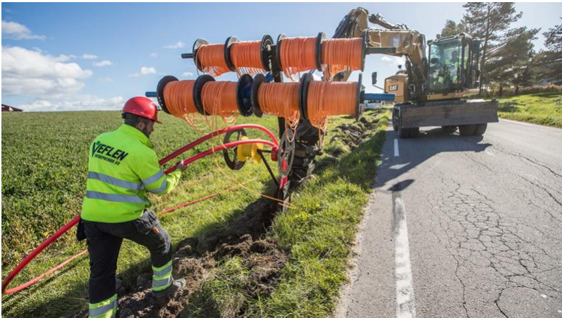
Figur 8 - Eksempel på fiberplog (foto: Jørn Söderholm, anleggsmaskinen.no )
